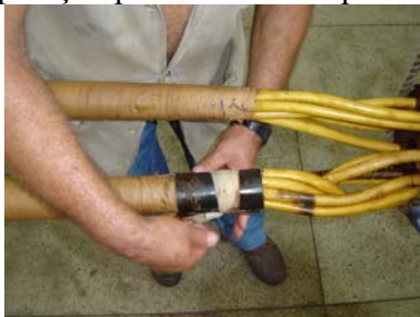
Preparação para retirada do papel
