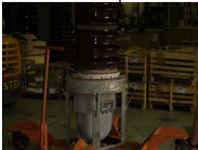
Preparação para retirada da porcelana
